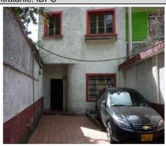
Vista de la fachada principal sobre la carrera 2. Área del lote: 193,74 mts2. Área construida en primer piso 104.33 mts2. Y en segundo piso 106.01 mts2. Porcentaje de ocupación: 54%. Uso original: Vivienda. La fachada principal se encuentra en alto grado de deterioro y agrietamiento. Un pino ciprés que estuvo localizado en el antejardín de la casa, generó afectaciones sobre el muro de la fachada.
